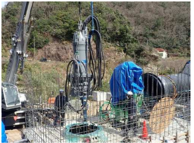
水中タービン発電機 (吊り込み作業)
